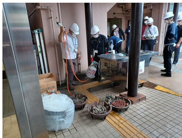
機材班によるコンロカートの設置
