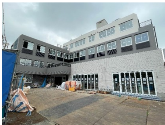
新施設外観の工事状況（6月末時点）
