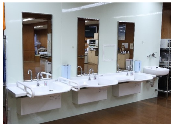
口腔ケアの状況もしっかり確認できる大きな鏡を設置し、使い勝手のよい洗面台
